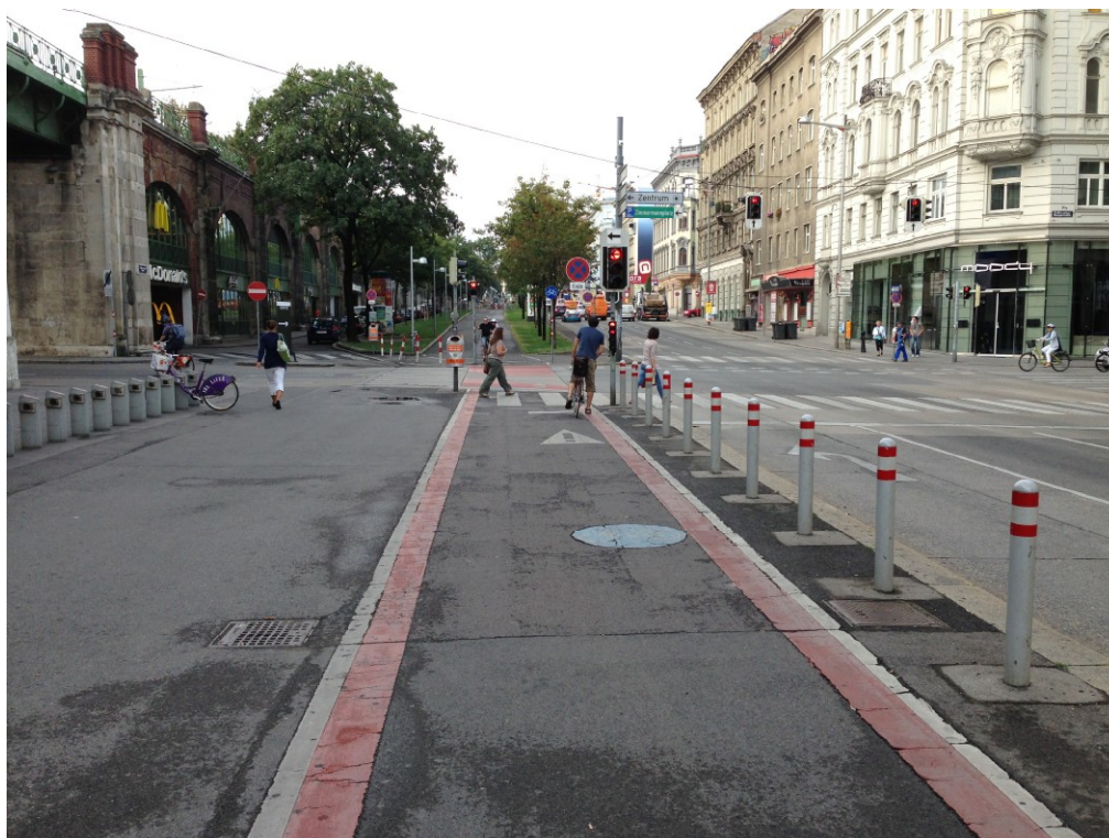
Obr. 3: Pás pro cyklisty s obousměrným provozem u stanice metra Alserstrasse ve Vídni, Rakousko
